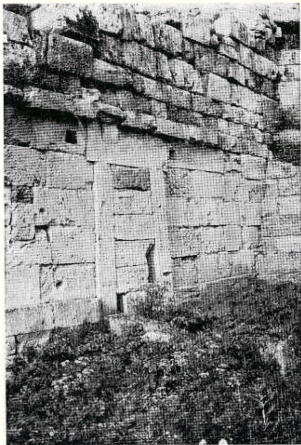
Fig. 3 — Porta del temenos sul tratto SE/NO del peribolo
