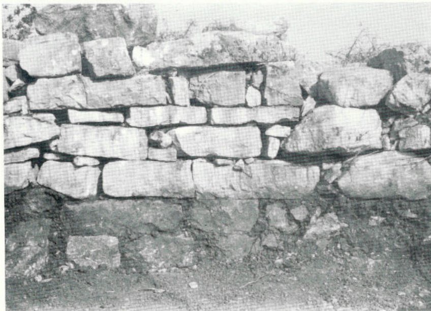
FIG. 7 - Collesano, Monte d'Oro: «Saggio I», particolare del «Muro A».
