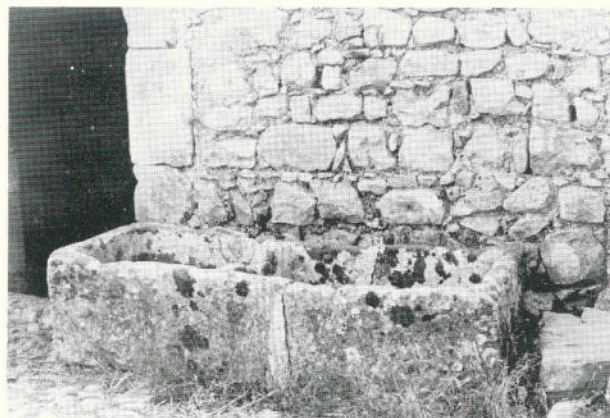
FIG. 3 - Vasca per decantazione d'olio.
