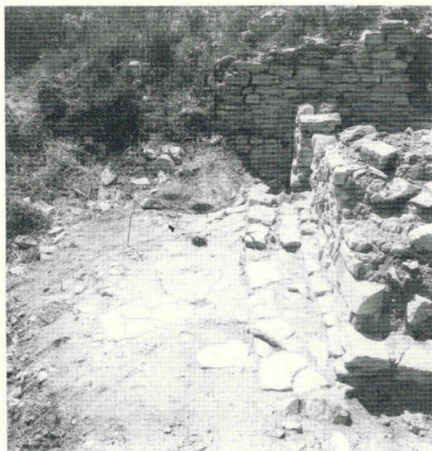
Sol de plâtre du bâtiment 2 (éventré par une tranchée).
