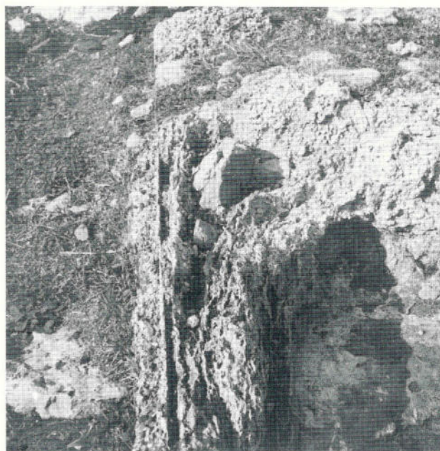
FIG. 8 - Angolo di una vasca dello stabilimento di S. Vito. Si noti la sovrapposizione di diversi strati di cocciopesto.
