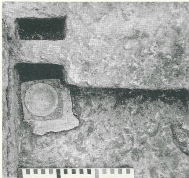
**Fig. 9 - Una delle boccole di bronzo nella porta settentrionale del bouleuterion.**
