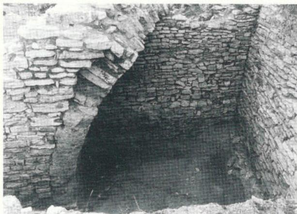
FIG. 12. La volta portante della scala (a destra, il muro Est dell'edificio 1).
