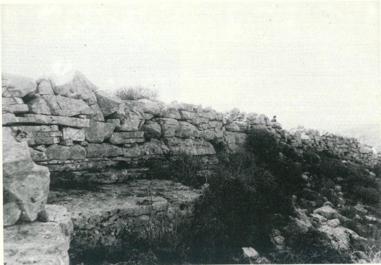
**Fig. 12 - Casale di sopra: rilievo fortificato; parte centrale del versante settentrionale. Il tratto meglio conservatosi dell'intera fortificazione: è ben visibile il piano roccioso livellato, forse in parte artificialmente, su cui è stata eretta la struttura.**
