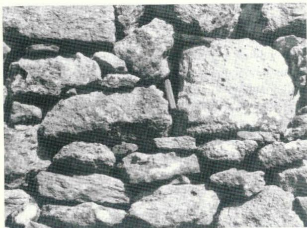
Fig. 5 - Materiali ceramici utilizzati per zeppare le pietre dei muretti a secco
