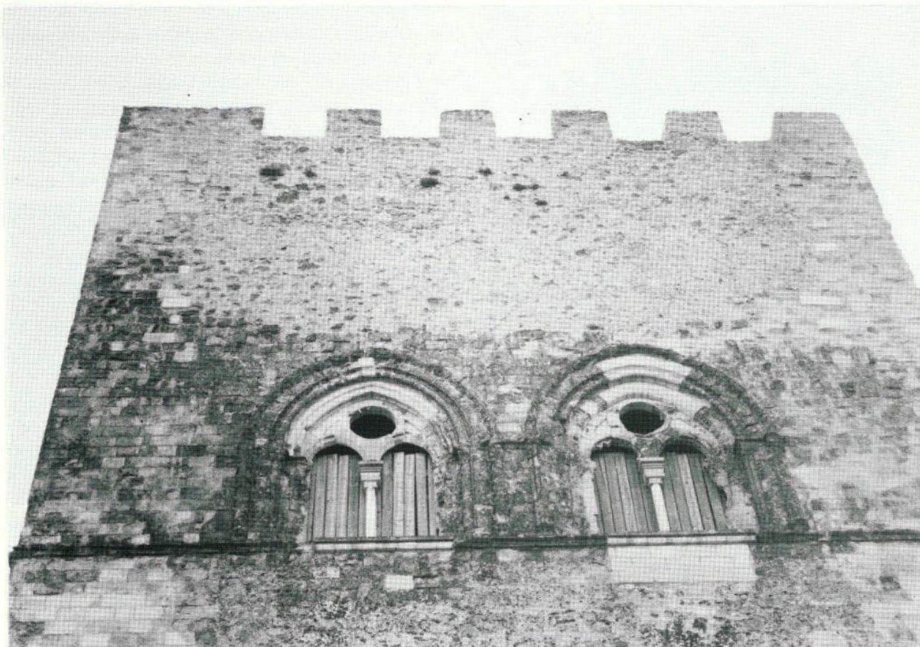
Fig. 11 - Naro: particolare del torrione quadrangolare
