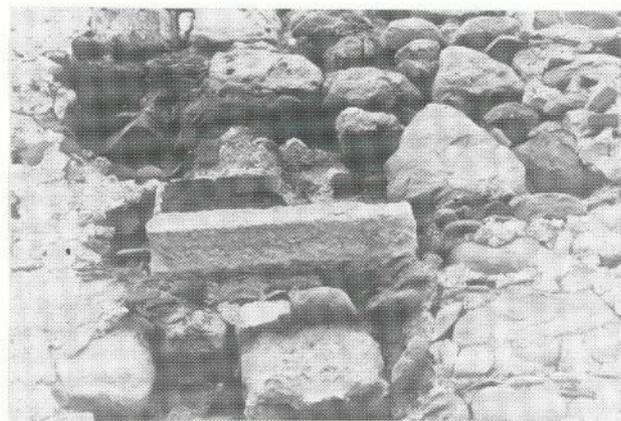
Fig. 21 - Prospetto N: probabile elemento di spoglio.
