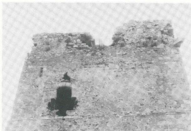
Fig. 20 - Prospetto N: finestra e feritoia del secondo piano e resti del coronamento a beccatelli.
