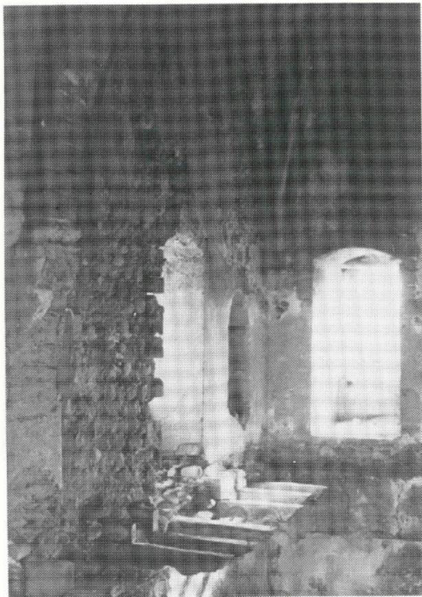
Fig. 46 - Finestre con volta ad arco ribassato e nicchia sui lati E e S del secondo piano.
